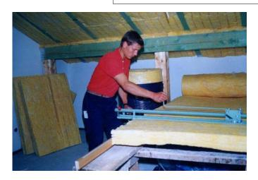
Exakter, winkelgerechter und sauberer Schnitt; dadurch kein Faserflug und Schneidestaub
