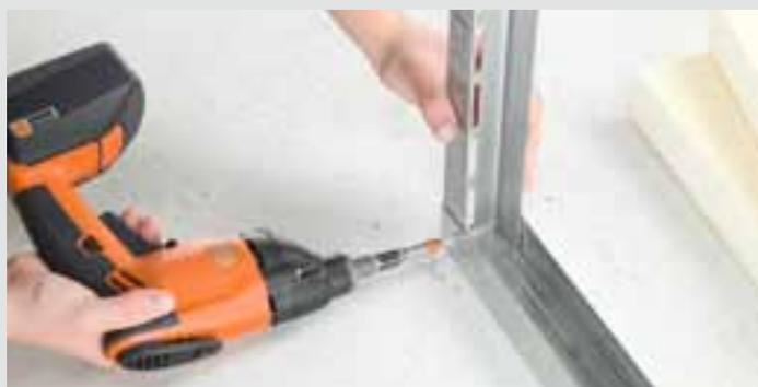
Mit dem Gasgebeschalter und der robusten Bauweise sind auch harte Schraubfälle im Trockenbau kein Problem. Damit sind die FEIN Trockenbauschrauber ideale Problemlöser – in allen Bereichen.
