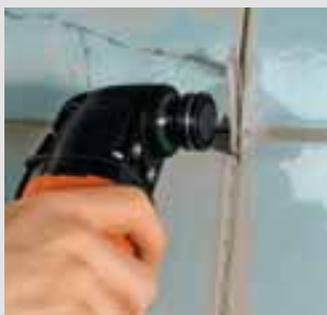
Hervorragend geeignet für das Austrennen besonders harter Fliesenfugen wie z. B. von unbegrenzt wasserfesten Epoxydharzfugen in Schwimmbädern.
