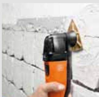
Mit der Staubabsaugung, passend für die Netzmaschine FSC 2.0 Q, lässt sich Schmutz und Staub beispielsweise beim Abtrag von dicken Fliesenkleberschichten oder mehreren Millimetern Putz vermeiden.
