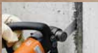
Die spezielle Zubehör-Ausstattung ermöglicht das Austrennen schadhafter elastischer Dichtstoffe im Hoch- und Tiefbau mit bis zu 60% Zeitersparnis. Auch geeignet für das Entfernen schadstoffbelasteter Fugen.
