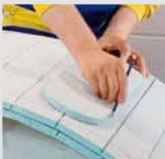
Im Profi-Set Heizungs-/Sanitärinstallation sind alle drei Aussparwerkzeuge enthalten: 12 mm für Elektrokabel, 13 mm für Elektro-, Wand- und Objektheizungen, 22 mm für Fußboden- und Wasserrohre.
