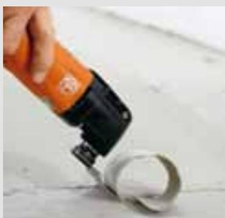
Neue Bodenbeläge benötigen einen sauberen Untergrund. Mit der Spachtel lassen sich auch hartnäckige Reste alter Bodenbeläge und Kleber entfernen.
