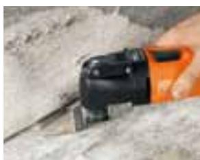
Neue Bodenbeläge benötigen einen sauberen Untergrund. Mit der vergrößerten Spachtel lassen sich hartnäckige Reste alter Bodenbeläge und Kleber zügig entfernen.
