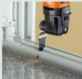
Mit den FEIN E-CUT-Sägeblättern trennen Sie die Fensterrahmen zügig und ohne Kraftaufwand aus. Beschädigungen an Rollladenkästen oder Fensterbänken sind prinzipbedingt fast ganz auszuschließen.
