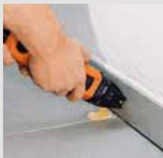
Für besonders schmal ausgeführte Fliesenfugen ist zusätzlich zum 2,2 mm breiten diamantbeschichteten Segmentmesser ein extra dünnes, nur 1,2 mm breites hartmetallbeschichtetes Segmentmesser enthalten.
