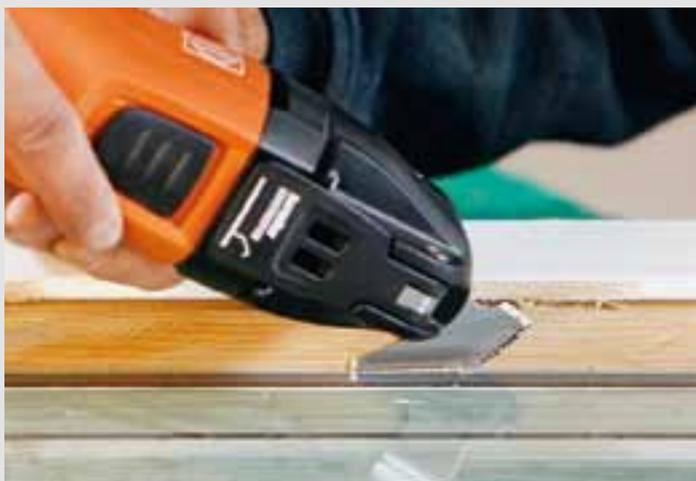
Kittbettverlegte Isolierglasscheiben können Sie mit dem segmentförmigen Schneidmesser vor Ort am Stück austrennen, ohne sie zerschlagen zu müssen. Das bedeutet: Praktisch keine Verletzungsgefahr, keine aufwendigen Aufräumarbeiten und eine Zeitersparnis von bis zu 80%.
