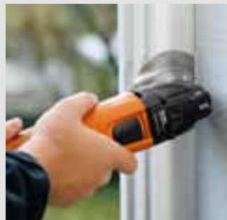
Mit dem HSS-Sägeblatt ist ein Altfenster-Ausbau auch in sensiblen Fällen möglich. Wandbeschädigungen können vermieden werden, das Sägeblatt liegt plan auf dem Rahmen auf. Metall-Befestigungen werden problemlos durchtrennt.
