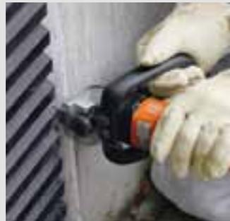
Die Absaugvorrichtung kann sowohl beim Austrennen des Fugenmaterials als auch beim Aufräumen der Fugenflanken mit dem diamantbeschichteten Reinigungsmesser eingesetzt werden.
