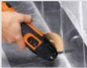
Beim Entfernen schadhafter Fliesenfugen in Ecken und an Kanten kommt das Hartmetall-Segmentsägeblatt zum Einsatz – für exaktes Arbeiten ohne Überschneidungen.
