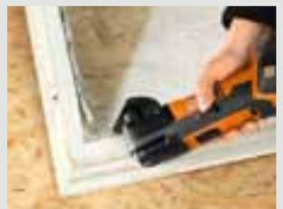
Brüchige Kittfasen lassen sich beim Ausglasen mit dem HSS-Segmentsägeblatt problemlos und ohne Glasbruchgefahr bis in die Ecken vollständig entfernen.
