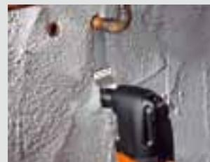
Ideal zur Demontage nicht mehr benötigter Installationen: mit den E-CUT Universal-Sägeblättern werden die Rohre für ein späteres Verspachteln wandbündig abgetrennt.
