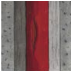
Oberflächenverletzung bei Polyurethan
