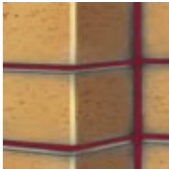
Gefahr bei Silikon: Randzonenverschmutzung
