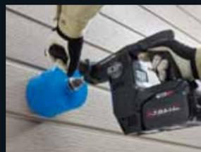
Panel Bohrungen mit Lochkreissäge (ø160 x 16mm)
