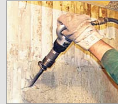
Abschlagen von Putz und Fliesen ohne viel Mühe
