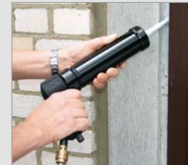
Spritzen – Fugen professionell und sauber verfüllen
