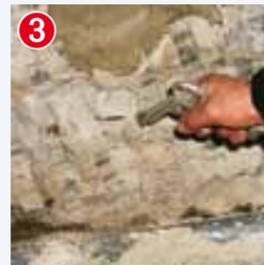
2 Bohrlöcher bei **K6** einreihig, bzw. bei **Kiesey** zweireihig im Zickzackmuster mittels Bohrmaschine erstellen.
