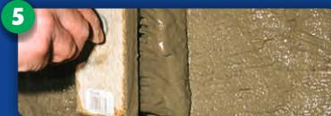
**Folgearbeiten - Fläche abdichten:** Die Fläche unterhalb der abgedichteten Lagerfuge mit K11 Flex Schlämme grau in zwei Schichten absperran.
