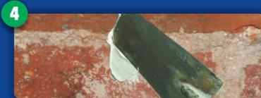
**Bohrlöcher schließen:** Die Bohrlöcher sind nach der Injektage mit einem schnell abtrocknenden Reparaturmörtel (z. B. Rapid 5) zu schließen.
