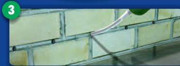
**Hydrophobierungscreme einbringen:** Kiesey Injektcreme mit Handfugpistole über Injektionsschlauch einmalig in die Bohrlöcher injizieren.
