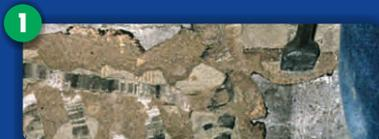
**Untergrund vorbereiten:** Altputz abschlagen, Mauerwerk reinigen, mürbe Mörtelfugen auskratzen und vollflächig mit Antisulfat behandeln. Ausgekratze Fugen mit Sperrmörtel fein verfüllen.
