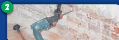
**Bohrlöcher erstellen:** Bohrlöcher einreihig mittels Bohrhammer ca. 15 cm über Oberkante Erdreich anordnen. Der Bohrstaub ist gründlich zu entfernen.
