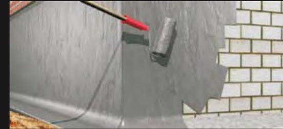
• **Reparaturarbeiten Dachbereich:** Zum Abdichten von u. a. Schornsteinanschlüssen, Lichtkuppeln, Rand- und Eckbereichen auf Flachdächern, Regenrinnen.
