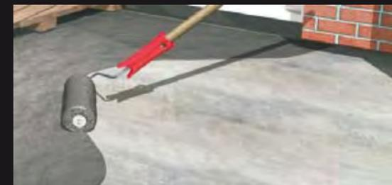
• **Flachdachabdichtung:** Zum Abdichten von Flachdächern unter Einbettung eines Glasgittergewebes in besonders rissgefährdeten Bereichen.
