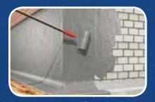
Betonfertigteile: Aqua Blocker<sup>®</sup> ist als außenliegende streifenförmige Abdichtung von Bauteilen aus Beton mit hohem Wassereindringwiderstand gemäß Bauregelliste A, Teil 2, lfd. Nr. 1.4 (abP) gegen drückendes Wasser, nicht drückendes Wasser und Bodenfeuchte bauaufsichtlich zugelassen.
