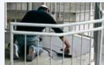
Balkonabdichtung unter keramischen Belägen
