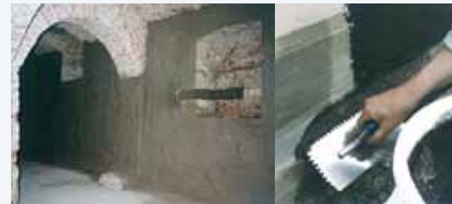
Nachträgliche Innenabdichtung bei Sanierungsarbeiten
