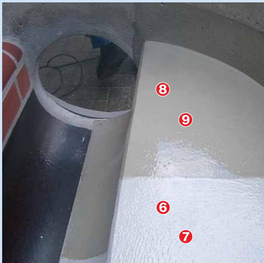
**6** HEY'DI Korrohaft plus im Bermenbereich als Haftbrücke zwischen dem mit Spezialsystem Aquastopp abgedichteten Untergrund und nachfolgenden Gefälleestrich aufbringen.
