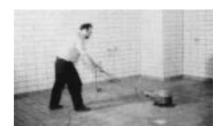
Als geeignete Fugmaschine kann z. B. Type EFS-70E, Firma Früh, 73614 Schorndorf, verwendet werden. Nachdem die Fugen verfüllt sind, wird überschüssiges Material mittels Weichgummischieber oder ARDAL Schlämmkelle WFB-weich von der Fliesenoberfläche abgezogen.
