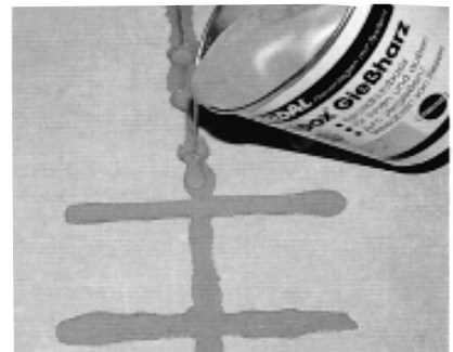
Unipox Gießharz im vorgegebenen Verhältnis (Teile A:B = 4:1) anmischen, Hohlräume ausgießen und Oberflächen danach absanden.
