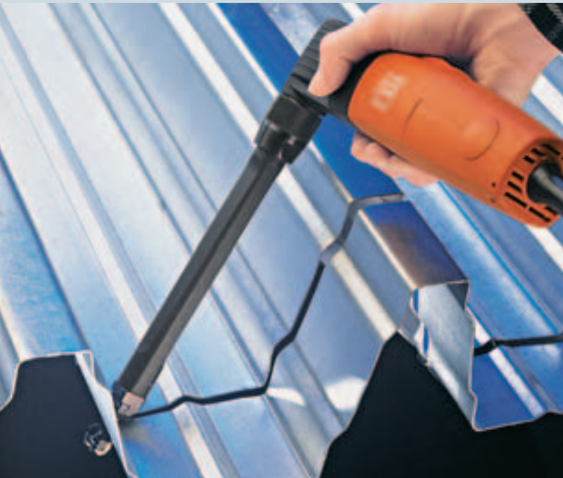
Tiefgesickte Trapezbleche bearbeiten ohne Kompromisse
