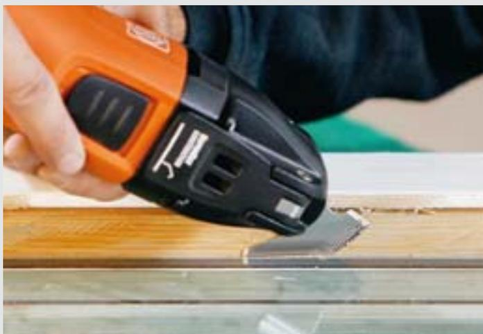
Kittbettverlegte Isolierglasscheiben können Sie mit dem segmentförmigen Schneidmesser vor Ort am Stück austrennen, ohne sie zerschlagen zu müssen. Das bedeutet: Praktisch keine Verletzungsgefahr, keine aufwändigen Aufräumarbeiten und eine Zeitersparnis bis zu 80%.
