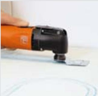
Mit dem FEIN Ausparwerkzeug wird der Kanal für eine Warmwasser-Fußbodenheizung direkt in die Bauplatte verlegt.
