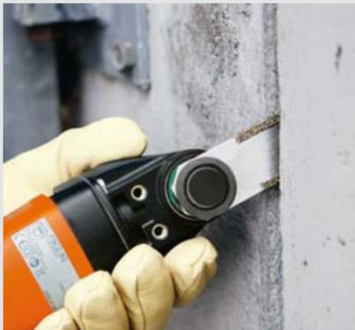
Das diamantbesetzte Reinigungsmesser reinigt die Fugenflanken vor der Neuverfugung und raut sie auf. Dadurch ist eine optimale Haftung des neuen Fugenmaterials garantiert.
