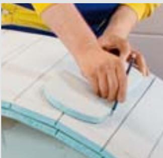
Im Profi-Set Heizungs-/Sanitär-Installation sind alle 3 Ausparwerkzeuge enthalten: 12 mm für Elektrokabel, 13 mm für Elektro-, Wand- und Objektheizungen, 22 mm für Fußboden- und Wasserrohre.
