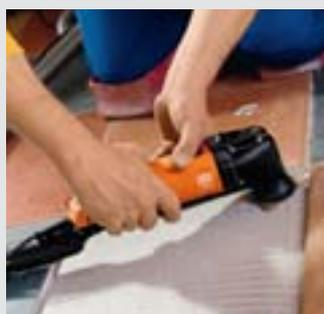
Beim Austausch einzelner Fliesen lassen sich selbst dicke Fliesenkleberschichten problemlos abschleifen. Die Staubabsaugung vermeidet dabei Schmutz und Staub.
