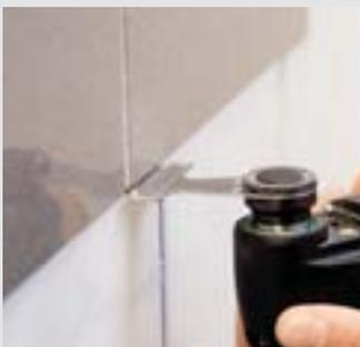
Mit dem Diamant-Segmentsägeblatt lassen sich Fliesenfugen ohne Beschädigung der benachbarten Fliesen austrennen. Der Staubanfall bleibt dabei äußerst gering – ideal für alle Reparaturen oder die Beseitigung einer Altinstallation.
