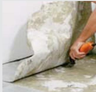
Teppich, Linoleum oder PVC-Bodenbeläge, Fliesenkleber oder Putz werden mit der Spachtel entfernt.
