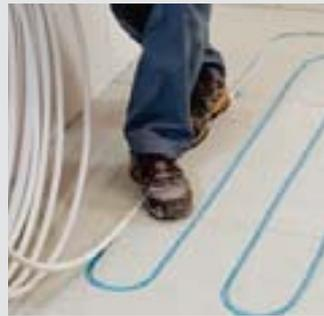
In die individuell geschnittene Aussparung ( $\varnothing$  ca. 25 mm) wird ein  $\frac{1}{2}$  oder  $\frac{3}{4}$  Zoll Kunststoff-Wasserleitungsrohr verlegt.
