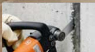
Ermöglicht das Austrennen schadhafter elastischer Dichstoffe im Hoch- und Tiefbau. Das System ist auch für schadstoffbelastete Fugen geeignet. Bis zu 60 % Zeitersparnis!
