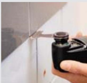
Das diamantbeschichtete Seg-mentmesser schneidet Marmor-, Epoxidharz- und Trassfugen. Die Fliesen können anschließend pro-blemlos zerschlagen und entfernt werden.
