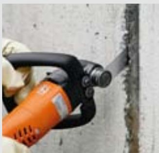
Alle elastischen Fugendichtstoffe schneiden Sie mit dem universell einsetzbaren, geraden Schneidmesser heraus. Ideal für Großobjekte: Der im Profi-Set enthaltene, kraftsparende und vibrationsgedämpfte Handgriff.
