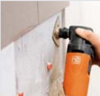
Mit der Hartmetall-Raspel lässt sich Fliesenkleber, Putz oder Estrich abtragen. Auf diese Weise kann die Ersatz-Fliese rasch eingesetzt werden.
