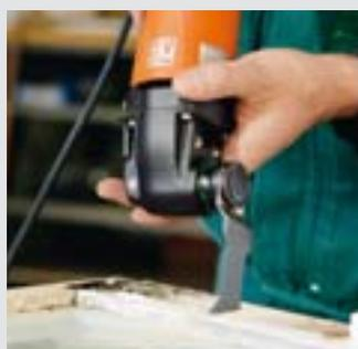
Beim Sanieren denkmalgeschützter Objekte werden verwitterte Fenster oft einzeln restauriert. Mit dem E-CUT Universal-Sägeblatt lassen sich beschädigte Flügelteile präzise austrennen und durch neue Holzteile ersetzen.
