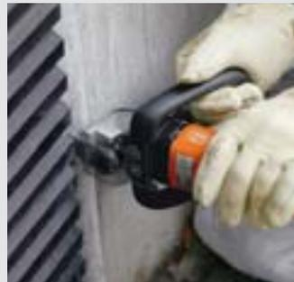
Die Staubabsaugvorrichtung kann sowohl beim Austrennen des Fugenmaterials als auch beim Aufräumen der Fugenflanken mit dem Diamant-Reinigungsmesser eingesetzt werden.
