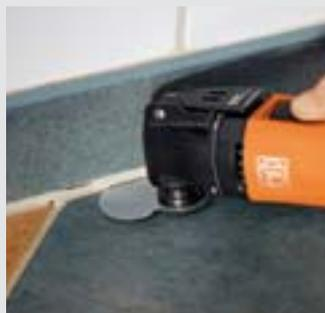
Schadhafte, elastische Silikon-oder Acryl-Anschlussfugen werden mit dem Schneidmesser in Pilzform schnell und rück-standsfrei entfernt. Neue Fugen-materialien können ohne Nach-arbeit aufgebracht werden.
