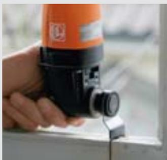
Mit den FEIN E-CUT-Sägeblättern trennen Sie die Fensterrahmen zügig und ohne Kraftaufwand aus. Beschädigungen an Rolladenkästen oder Fensterbank sind prinzipbedingt fast ganz auszuschließen.
