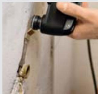
Alte, nicht mehr benötigte Kupfer- oder Kunststoffrohre werden mit dem FEIN SUPER CUT und E-CUT Universal-Sägeblättern wandbündig entfernt.
