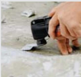
Neue Bodenbeläge benötigen einen sauberen Untergrund. Mit der Spachtel entfernen Sie hart-näckige Reste alter Bodenbeläge und Kleber im Nu.
