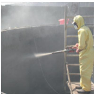
Flammstrahlen oder Fräsen vorbereitet. Auf stark sulfatgeschädigtem Beton empfehlen sich Betonersatzmörtel mit spezifisch sulfatbeständigen Eigenschaften. Für die Applikation von Hand eignet sich
