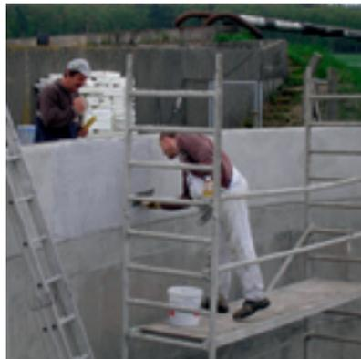
den Auftrag des Korrosionsschutzes **SikaCem®-210 KS** vor. Als Betonersatz eignet sich **SikaCem® Gunit-212 S**. Nach der Reprofilierung der Betonfläche kann – wenn keine oder nur geringe Biogene Schwefelsäurekorrosion (BSK) vorliegen – entweder mit **Sika® Kanal-Spachtel** oder mit dem epoxidharzvergüteten und spritzbaren Feinspachtel **Sikagard®-720 EpoCem** egalisiert werden.
