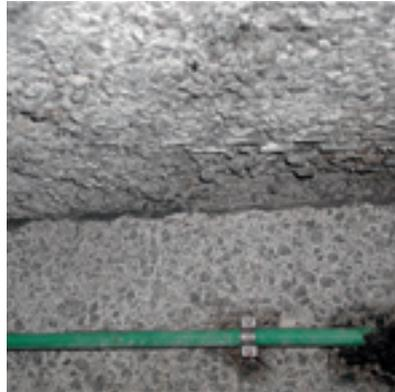
Diese sogenannte Biogene Schwefelsäurekorrosion (BSK) ist die schwerwiegendste Schadensursache im Innenraum von Biogasbehältern.
