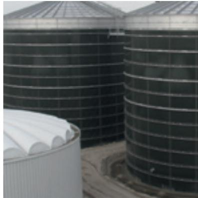
Montage der Stahlsegmente aus Edelstahl, Schwarzstahl oder für emaillierte Stahlsegmente. **Sikaflex®-TS plus** ist beständig gegenüber Jauche, Gülle und Silagesickersäfte, dafür liegen Prüfberichte des Süddeutschen Kunststoff-Zentrums (SKZ) Würzburg vor.
