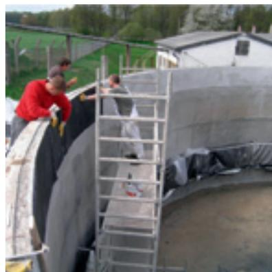
**Sikagard®-177**. Die abschließende Deckschicht besteht aus zwei Schichten **Sika® Permacor® 3326/EG-H**.
