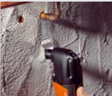
Ideal zur Demontage nicht mehr benötigter Installationen: mit den Universal E-CUT-Sägeblättern werden die Rohre für ein späteres Verspachteln wandbündig abgetrennt.
