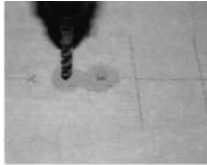
Bei feinen Rissen werden Löcher ( \geq \varnothing 12 mm) im Abstand von max. 10 cm bis ca. 2/3 der Estrichdicke gebohrt.
