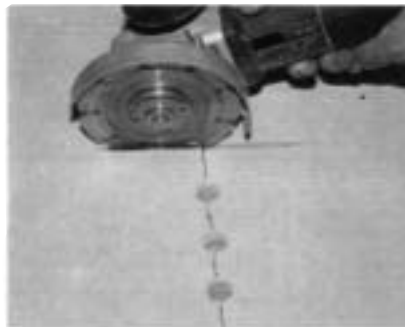
Risse und Scheinfugen sind durch Aufschneiden auf mindestens 6 mm zu erweitern.
